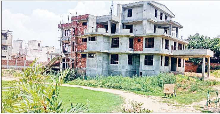
सोनीपत। गोहाणा रोड स्थित सुभाष स्टेडियम में निर्माणाधीन बहुउद्देशीय भवन।
